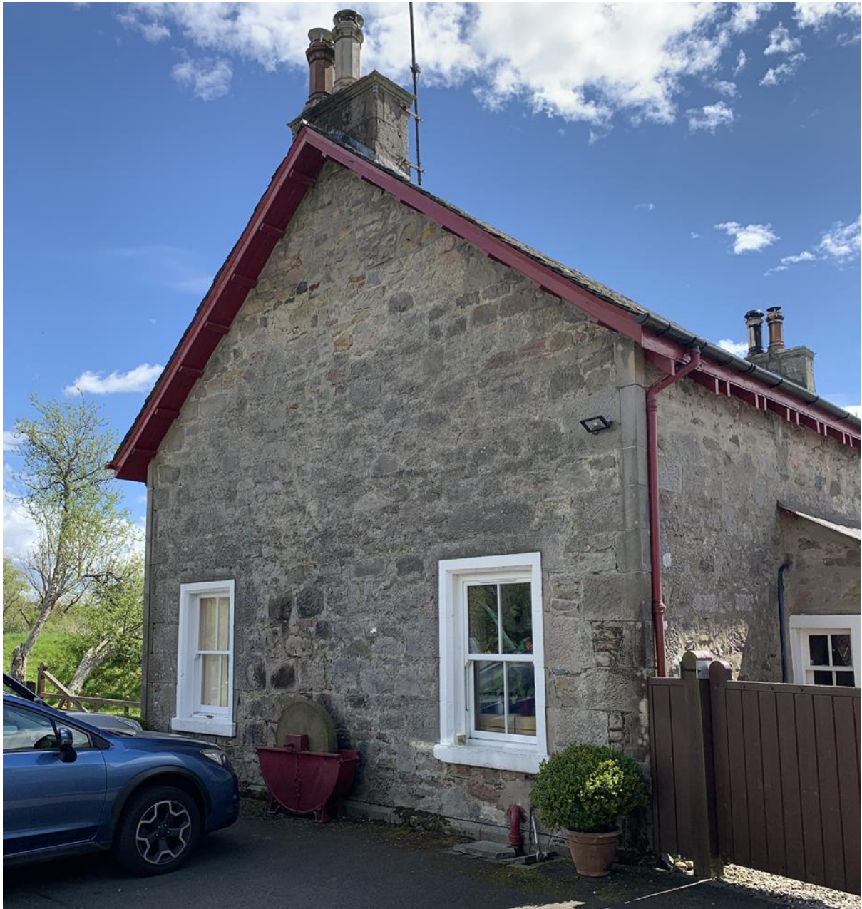
Figure 077.1. Auchentullich Farm Cottage.
