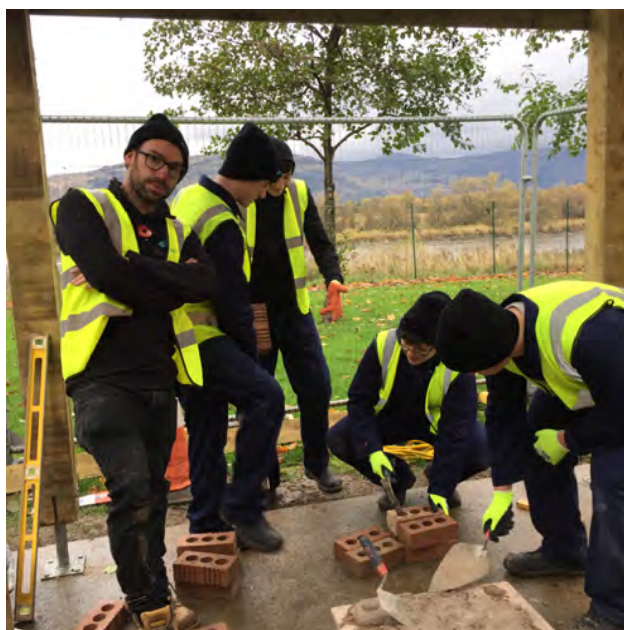
Rys. 7 i 8: Uczniowie współpracują z wykwalifikowanymi rzemieślnikami z HES przy budowie szopy na rowery o konstrukcji drewnianej z murowanymi fundamentami.
