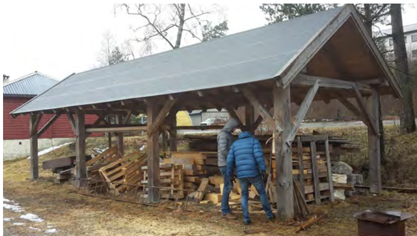
Rys. 6: Tradycyjna konstrukcja drewniana o nazwie Gapahuk. Konstrukcja ta była projektem szkoleniowym zbudowanym w ciągu dwóch tygodni przez uczniów drugiej klasy z Voss dla miejscowej rodziny. 34
